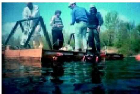
*Mit diesem Floß wurden die Betonblöcke über den See transportiert. Am Ziel wurden sie per Seilwinde abgesenkt.*
